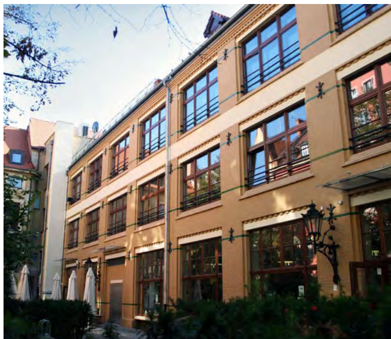
Siedziba Biura Literackiego Fot. Arch. BL, Wrocław
