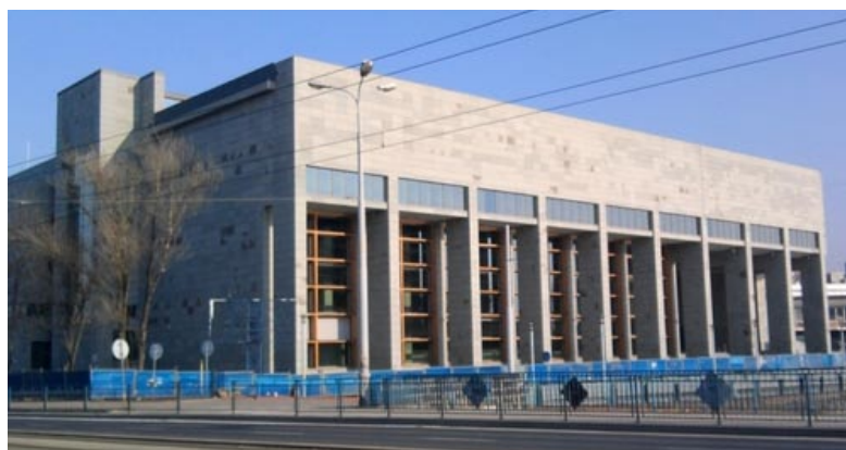
Nowy gmach Biblioteki Uniwersyteckiej we Wrocławiu Fot. Arch. BU we Wrocławiu
