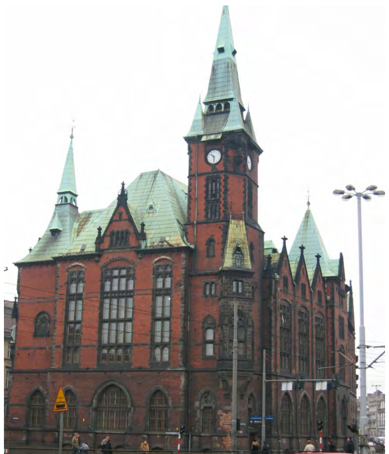
Budynek Stadtbibliothek. Fot. R. Werszler
