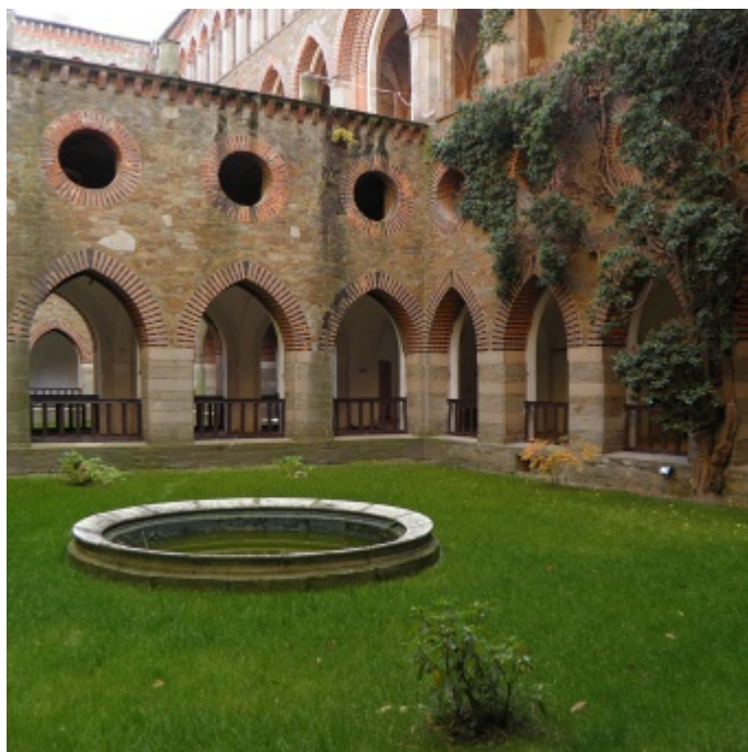
Dziedziniec pałacu w Kamieńcu Zabkowieckim. Widoczne półpiętro z okrągłymi oknami "dodane" przez Mariannę dla służby - poprowadzono tamtędy korytarze techniczne, znajdowały się w nim schowki i pokoje mieszkalne pracowników.
