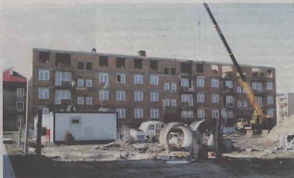
Trwa budowa piątego mieszkalnego bloku wielorodzinnego przy ulicy Mieszka I
