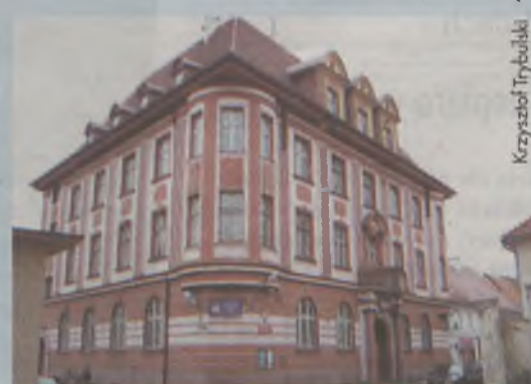
Oławska Komenda Powiatowa Policji wkrótce doczeka się gruntownego remontu
