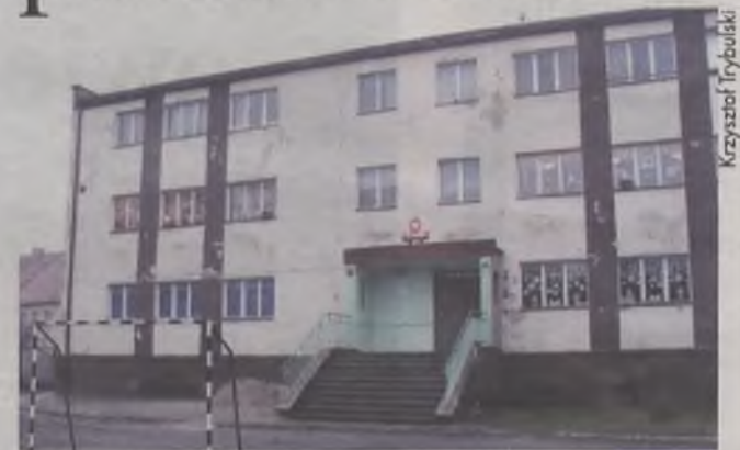
Tak wyglądał budynek szkoły w Danielowicach przed remontem
