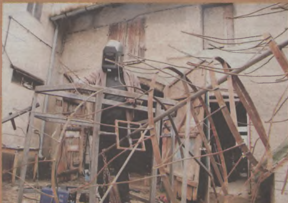
Konstrukcja jest stalowa. Na stelaż będzie naciągana siatka, którą trzeba pokolorować
