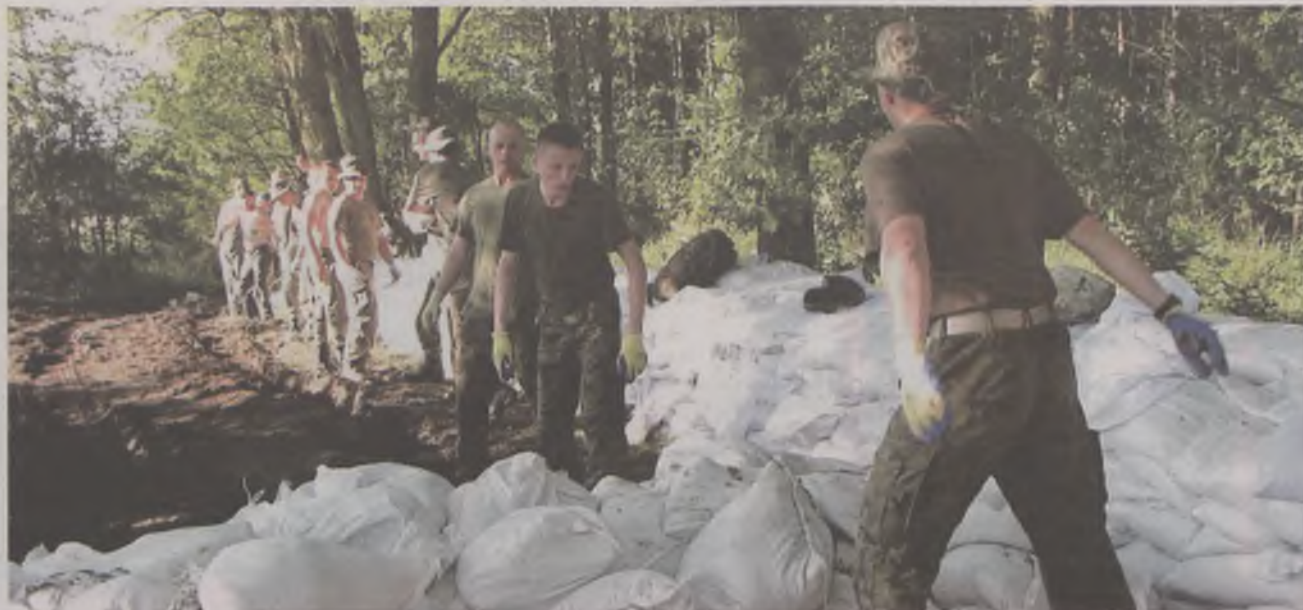
Przy budowie wałów pomagali żołnierze, strażacy, więźniowie i wolontariusze
