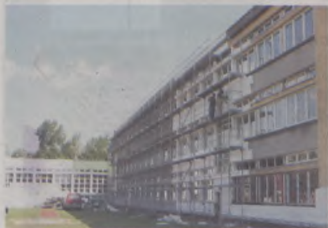
Trwa pierwszy etap termomodernizacji budynków szkolnych - ZSP nr 1 im. Tadeusza Kościuszki w Oławie...
