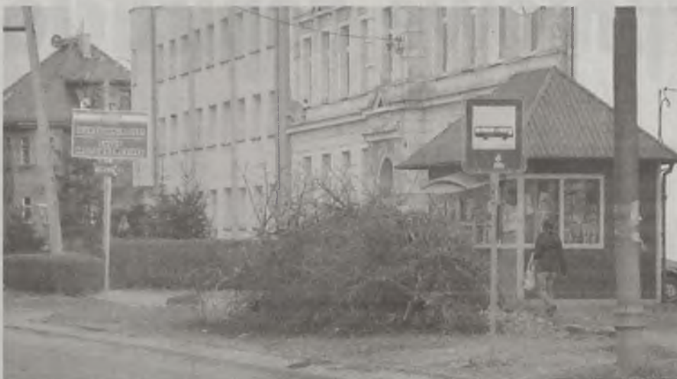
Przygotowania do gruntownego remontu ulicy 3 Maja rozpoczęto od wycięcia drzew i krzewów
