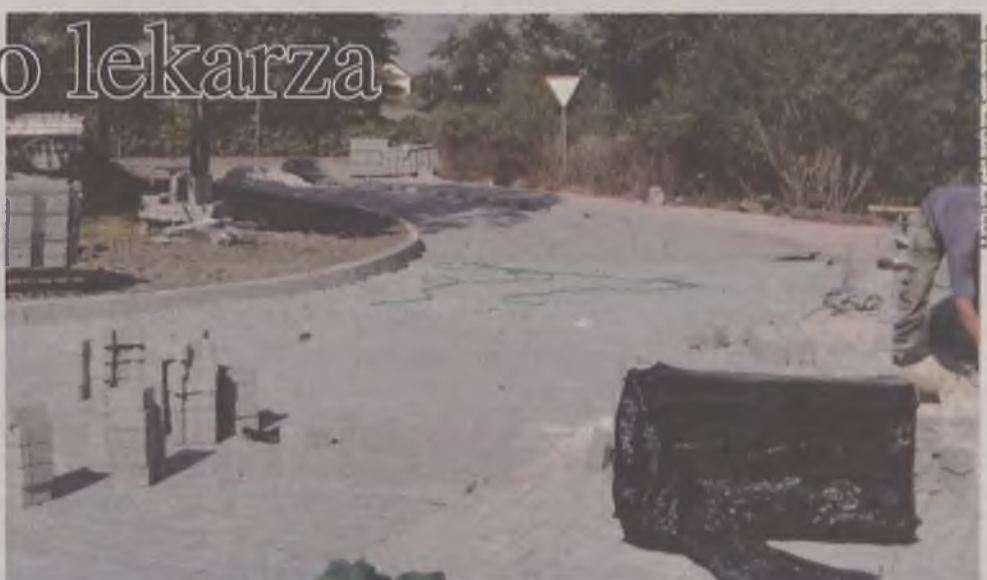
Praca nad odbudową drogi
