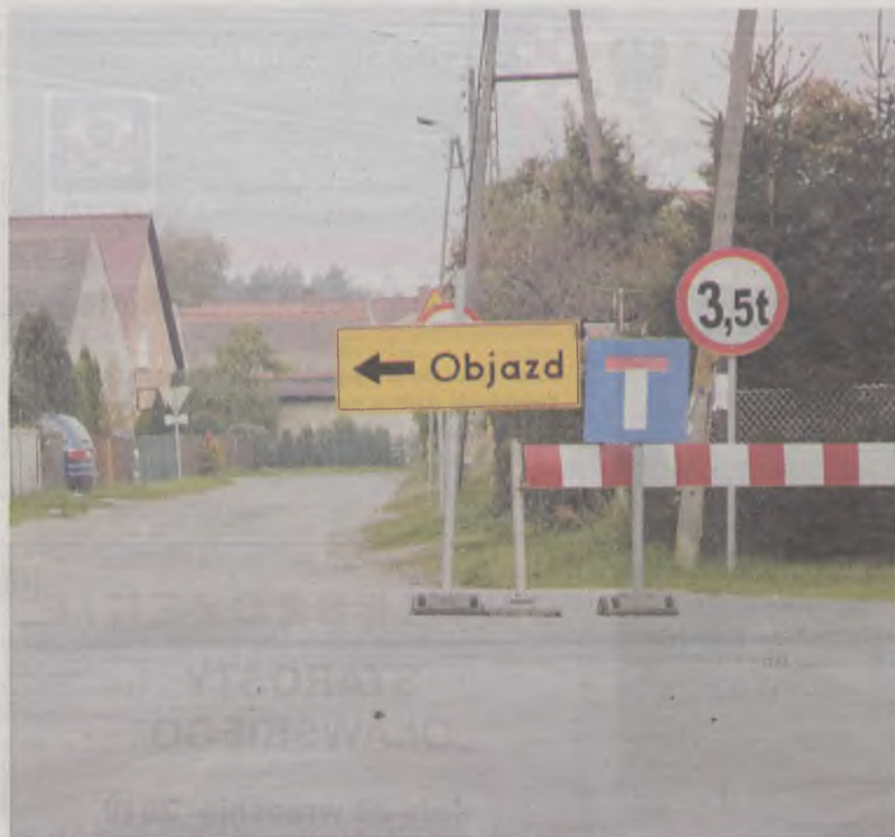
Droga z Janikowa do Jelcza-Laskowic przez Hannę będzie zamknięta do 11 października
