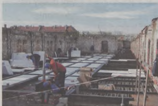
Prace na górnej kondygnacji są już mocno zaawansowane
