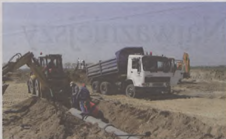
Budowa łącznika do drogi krajowej nr 94 do ul. Zacisznaj wraz ze skrzyżowaniami w Oławie.
