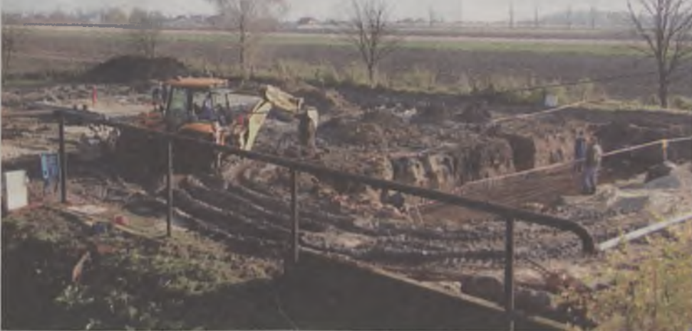
Do grudnia 2011 w tym miejscu ma powstać nowa oczyszczalnia ścieków
