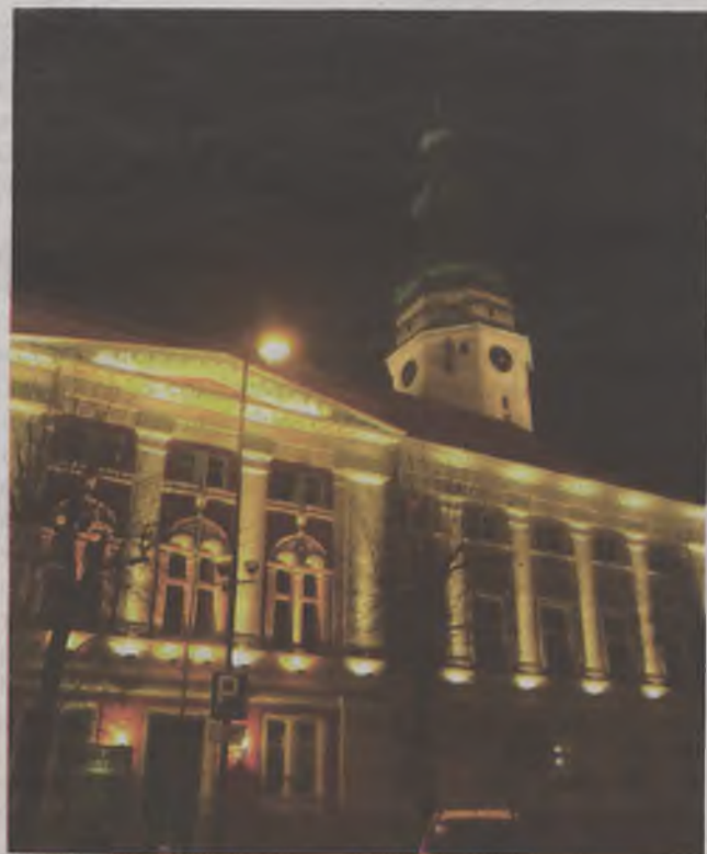
Przebudowa Ratusza w Oławie
