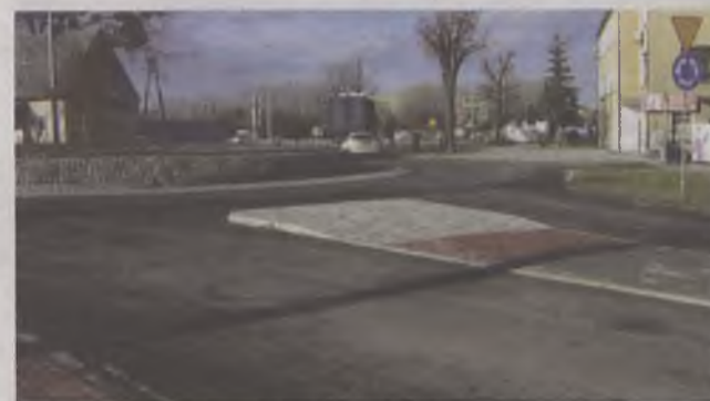
Przebudowa dróg powiatowych w kierunku autostrady A4 i drogi S8
