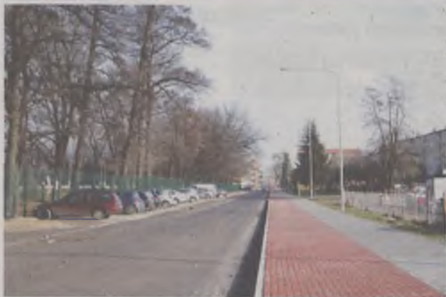
Odcinek ulicy Sportowej od strony Odry i Żeromskiego jest już gotowy
