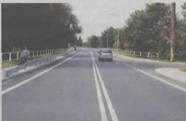
Dojazd do wiaduktu na Oławskiej, od strony ulicy Witosa w Jelczu-Laskowicach
