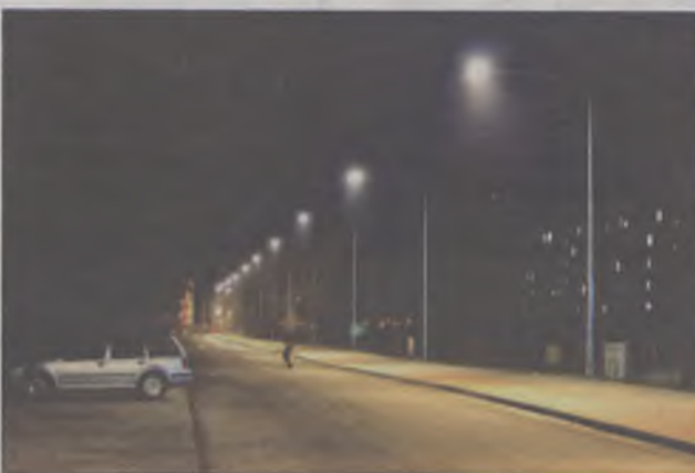
Wyremontowana jezdnia doczekała się także nowego oświetlenia
