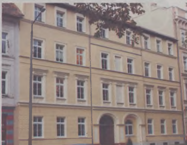
Wyremontowana kamienica, w której mieści się Powiatowy Ośrodek Pomocy Psychologiczno-Pedagogicznej i Doradztwa Metodycznego w Oławie
