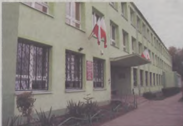
Budynek ZSP w Jelczu-Laskowicach po termomodernizacji
