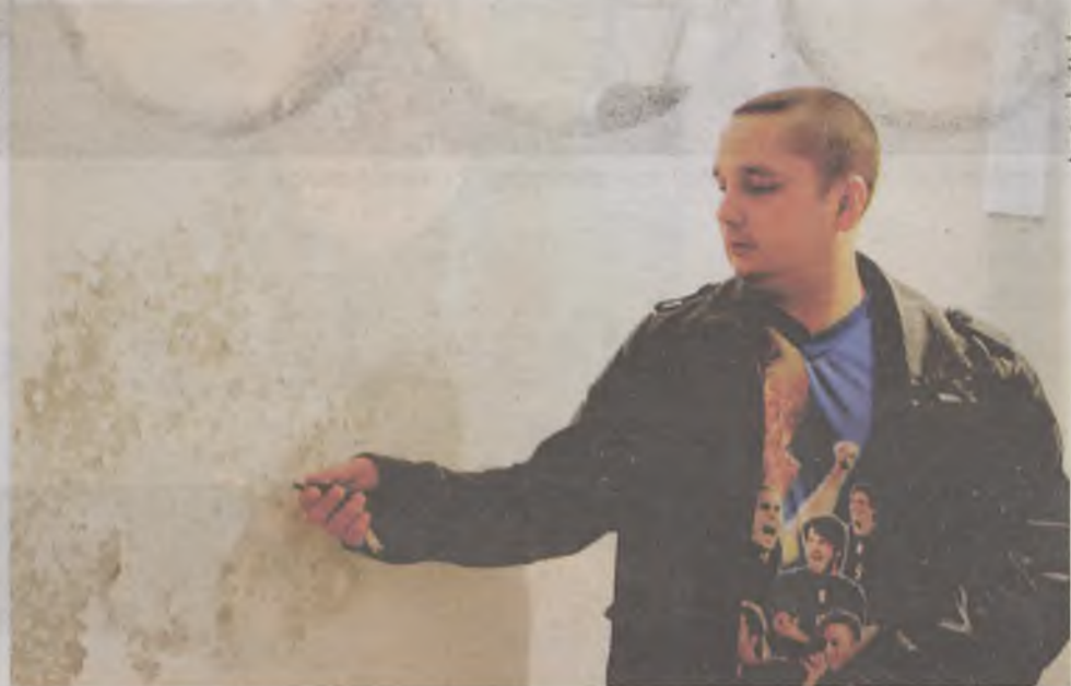
Dawid Karbowski od roku naciskał władze TBS, ale zlikwidowały problem wilgoci w budynku przy Andersa. - W piwnicach jest trzycentymetrowy grzyb - mówi kilka tygodni temu. Już pomalowano ściany specjalną farbą...
