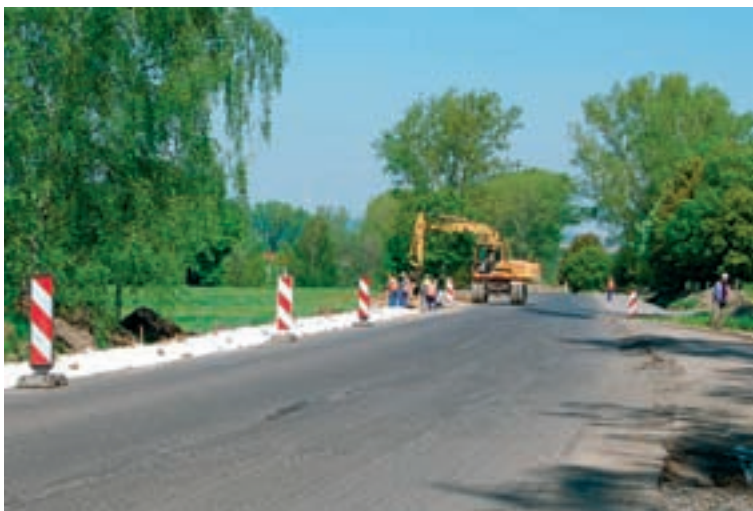
Prace na drodze wojewódzkiej do Bogatyni mogą potrwać nawet do wiosny przyszłego roku.
