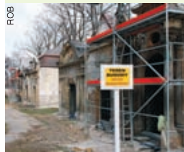
Prace przy remoncie kaplic już się rozpoczęły.
