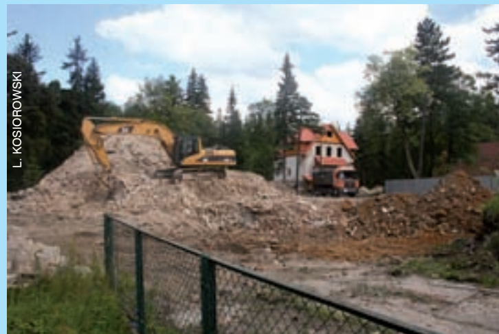
Biedronka ma powstać na miejscu wyburzonego Domu Wczasowego Medyk.
