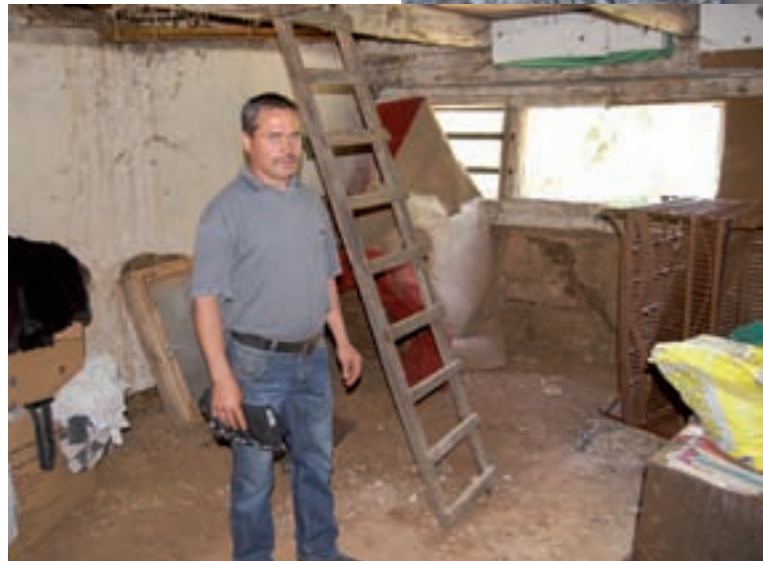
Tato Anety zastanawiał się dwa miesiące temu, czy to pomieszczenie w ogóle da się wyremontować.
