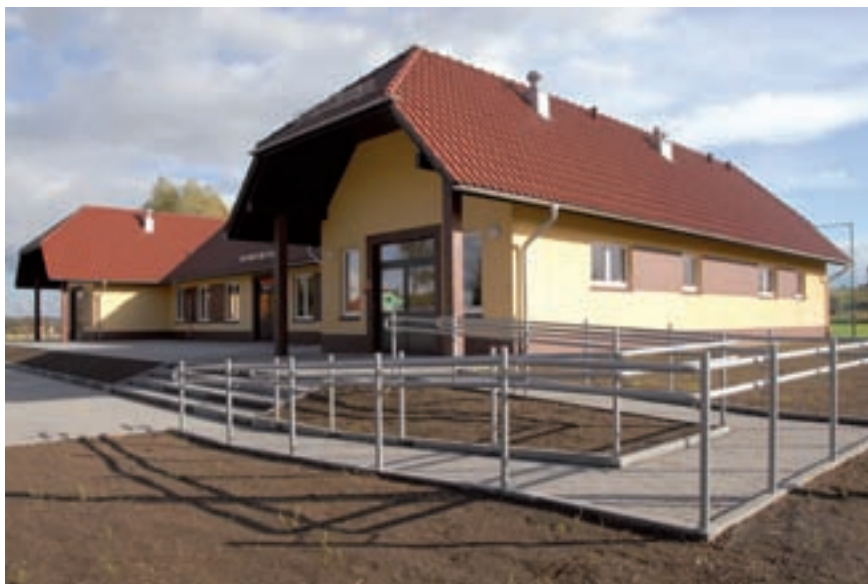
Jeszcze w październiku tego roku zaplanowany jest odbiór techniczny nowej świetlicy wiejskiej w Kotliskach.
