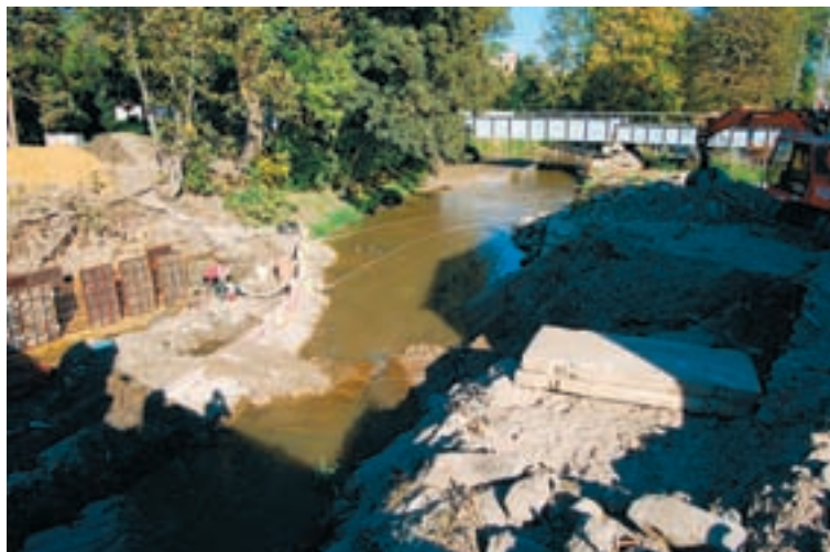
Na rzece cały czas trwają prace budowlane. Czy będą jednak zbieżne z nową, mającą dopiero powstać, mapą wodną?
