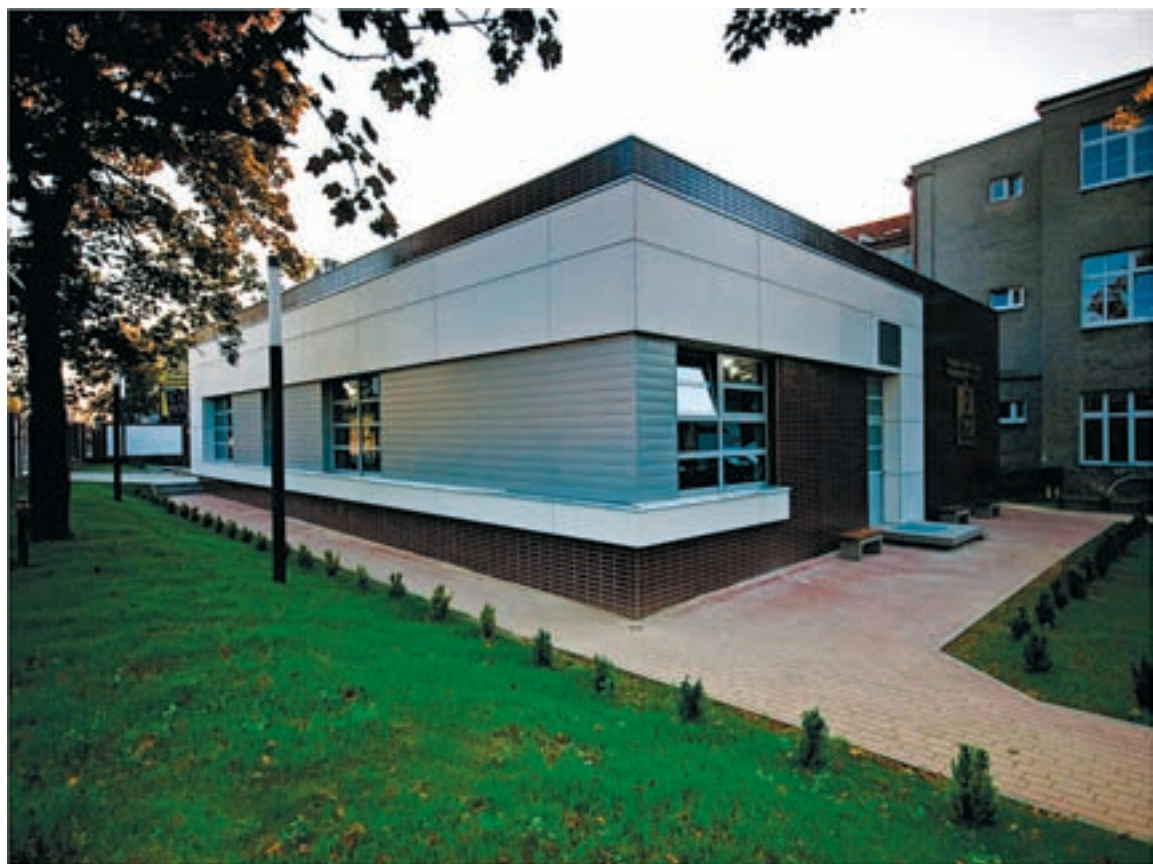
Nowy blok operacyjny w szpitalu Kamiennej Górze wybudowano za 5,7 mln zł
