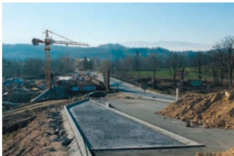
Budowa nowego mostu na Bobrze.
