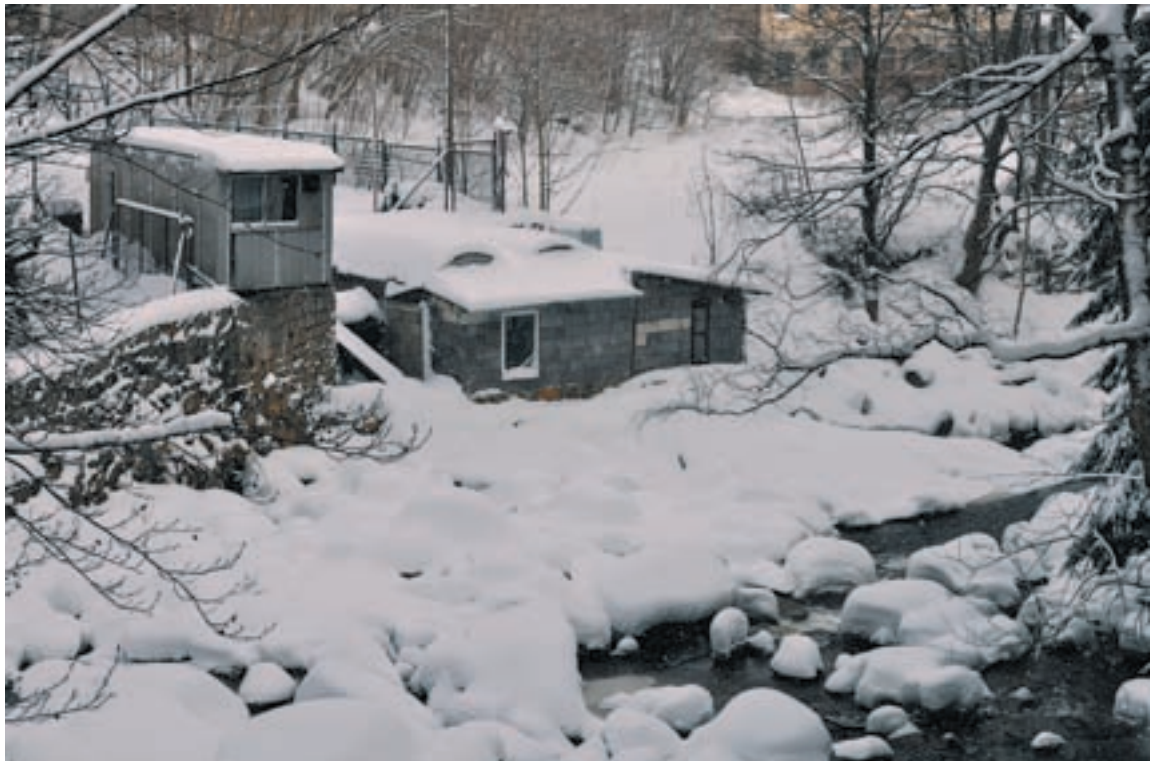
Budowa małej elektrowni, takiej jak ta na Kruczych Skałach, kosztowałaby co najmniej 500 tys. zł.
