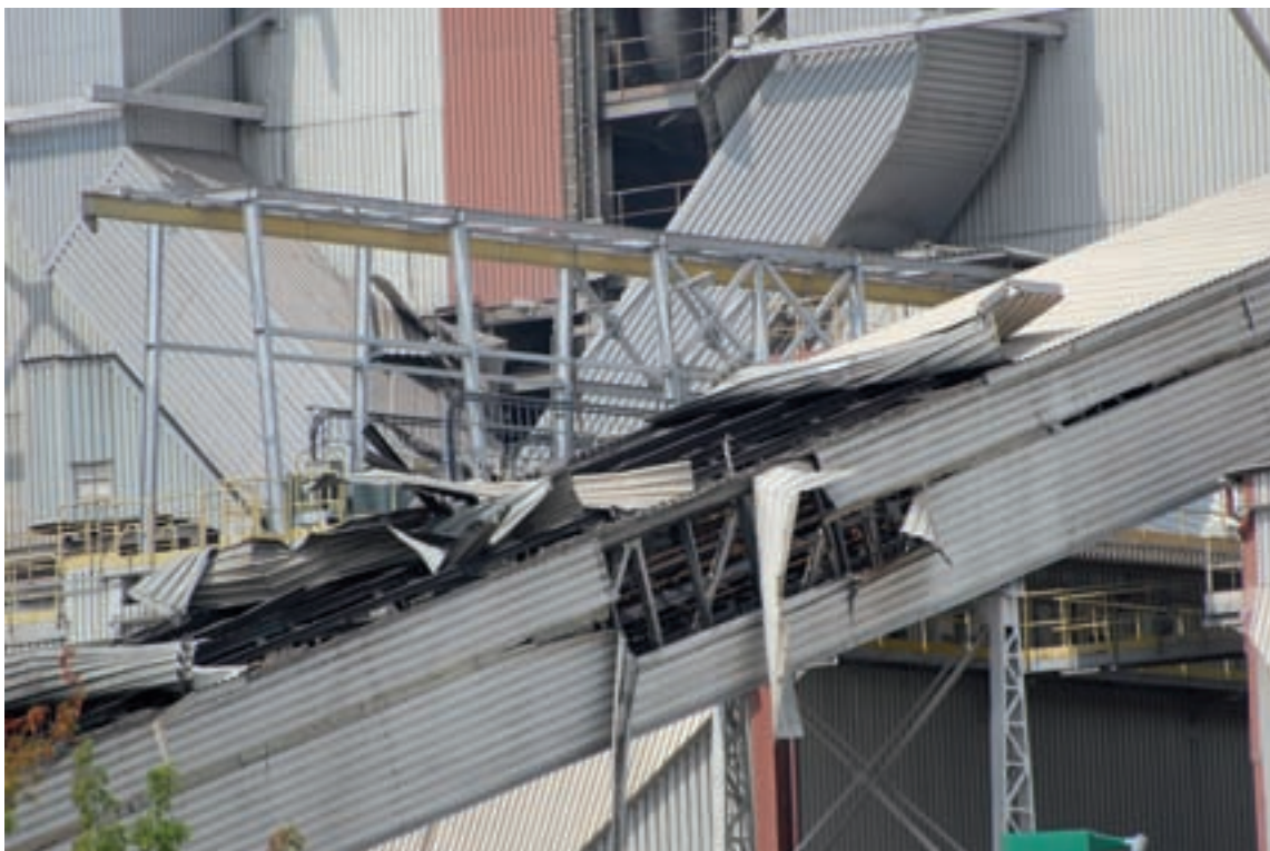
Jeden z uszkodzonych taśmociągów.
