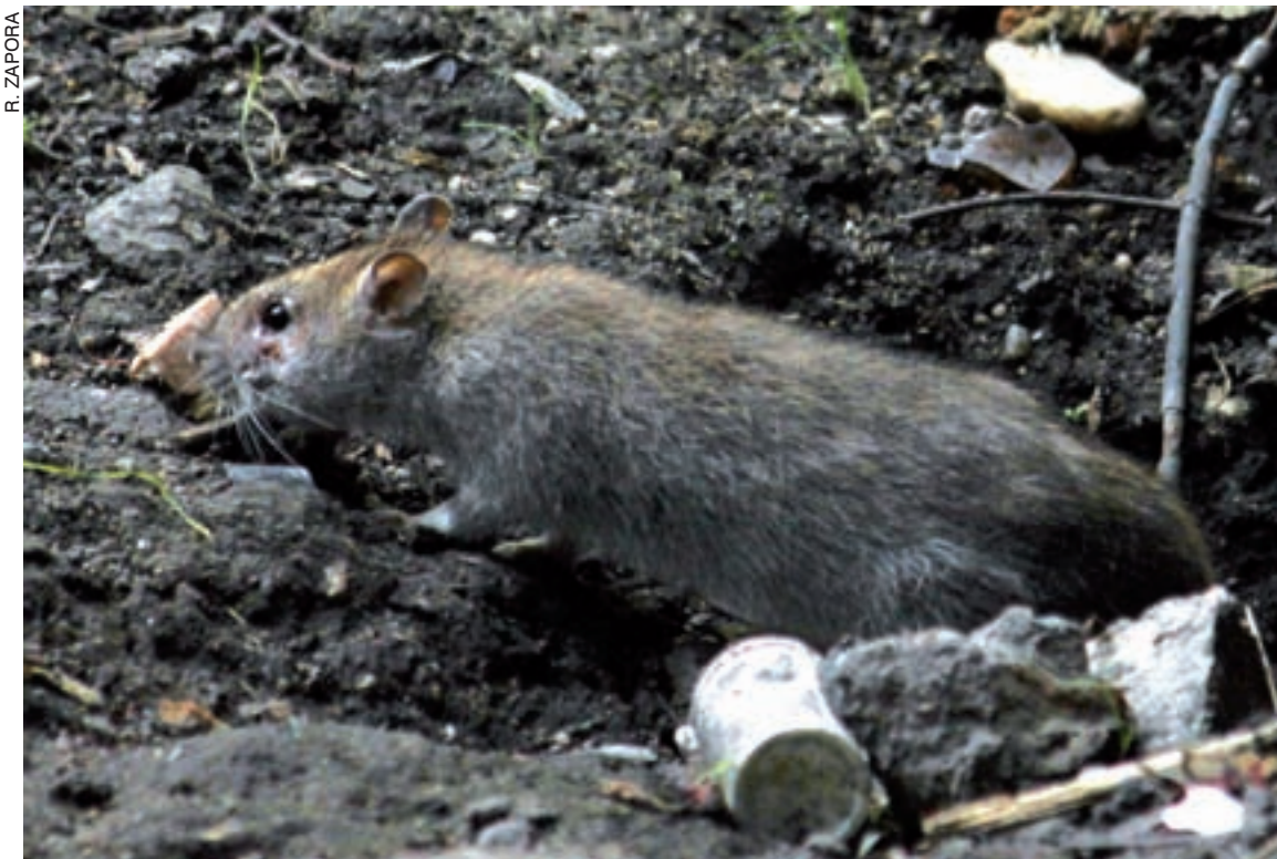
Szczur wyszedł dziurą przy instalacji odgromowej transformatora. Uwiecznił to nasz reporter.
