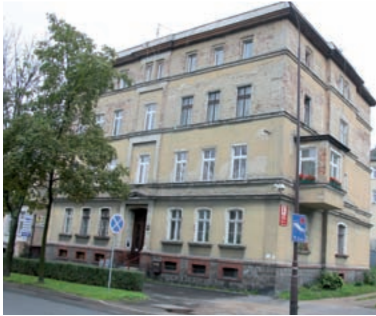
Remont elewacji budynku przy Wojska Polskiego 17 musi poczekać, bo wspólnota musiała zapłacić zaległości za wodę.
