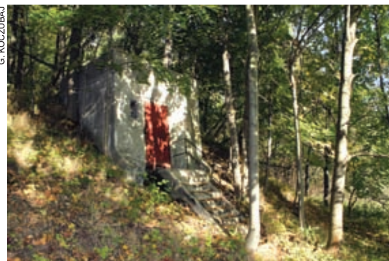
Ten budynek to nie ujęcie wody, lecz zbiornik wyrównawczy zasilany z ujęcia „Leśniczówka”.
