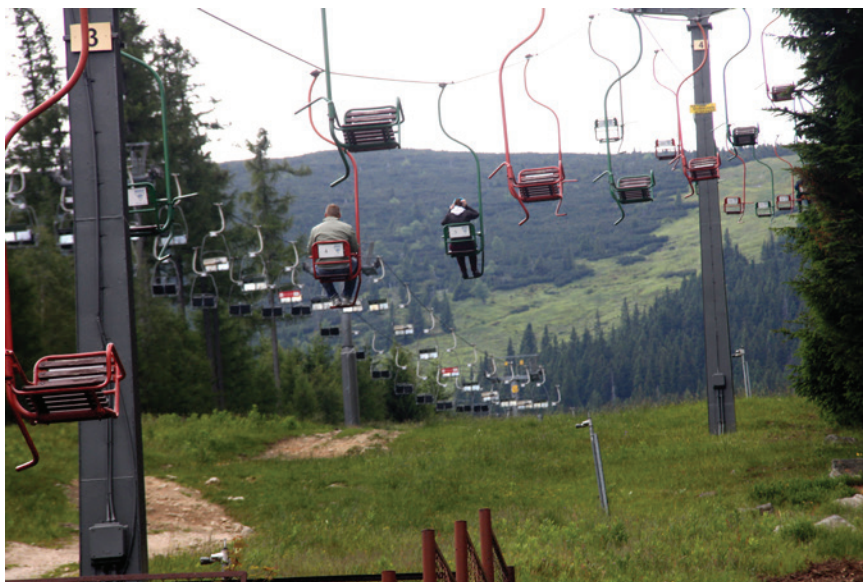
Kolej linowa w Karpaczu wymaga modernizacji.
