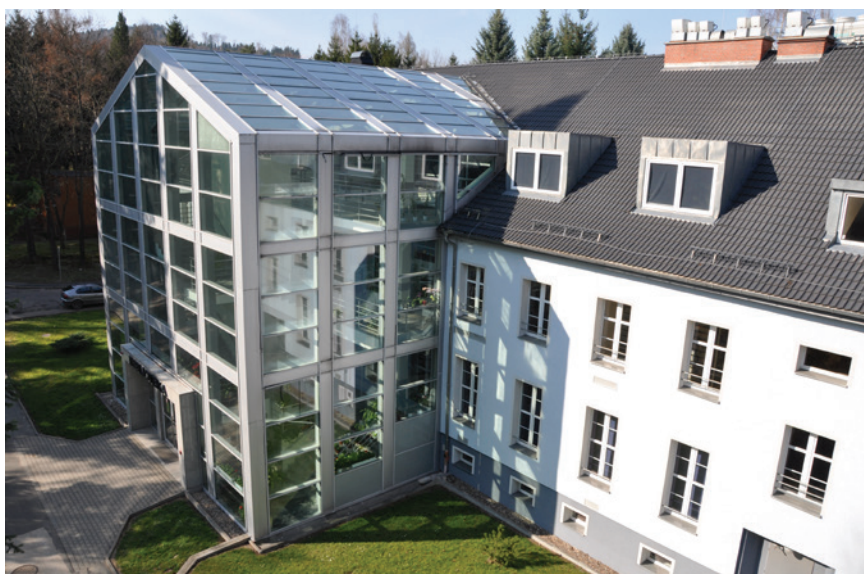
W bibliotece i innych budynkach zamontowane są windy.
