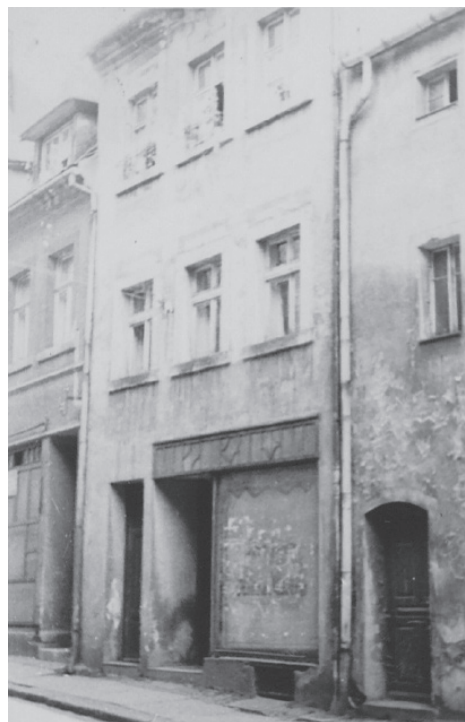
7. Budynek mieszkalny, ul. Buczka 55, ceglano-kamienny bez cech stylowych, wiek XVIII, XIX.
