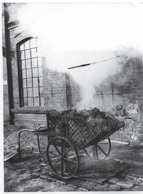
Piec retortowy z tzw. muldą do załadunku węgla oraz wózek do koksu
