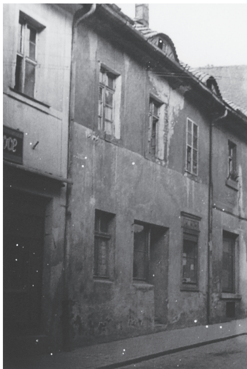
24. Budynek mieszkalny, ul. Świerczewskiego 4, ceglany bez cech stylowych, XVIII.
