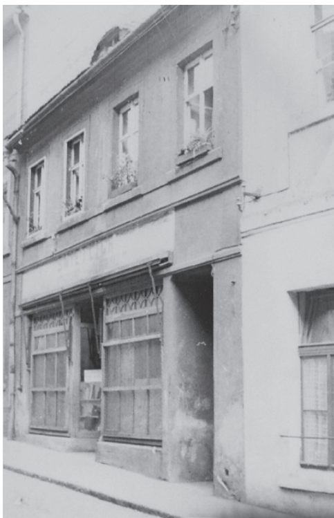
27. Budynek mieszkalny, ul. Świerczewskiego 11, ceglany bez cech stylowych, wiek XVII, XVIII.
