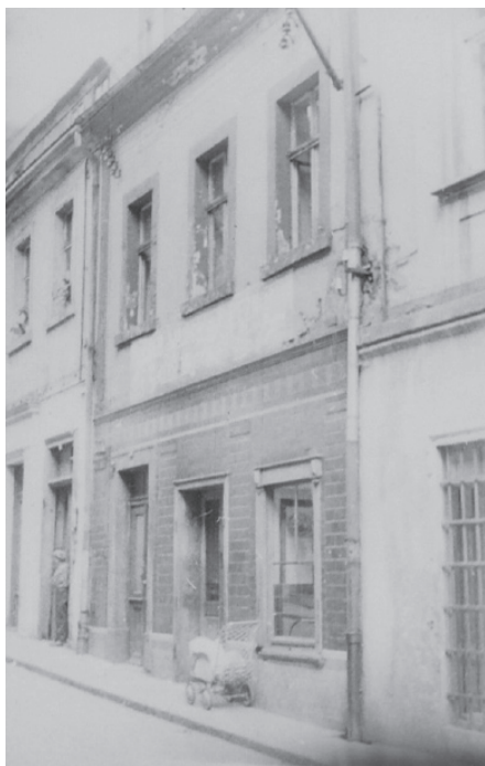
28. Budynek mieszkalny, ul. Świerczewskiego 13, ceglano-kamienny bez cech stylowych, wiek XVII, XIX.
