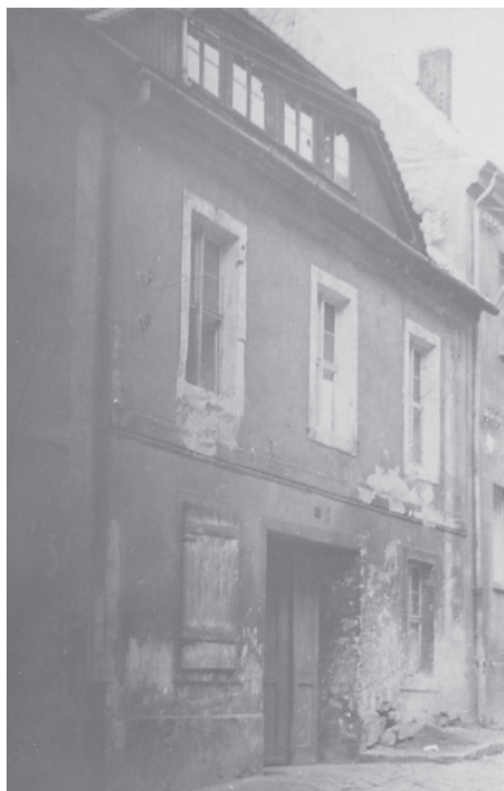
9. Budynek mieszkalny, ul. Felczerska 11, ceglany bez cech stylowych, wiek XIX.
