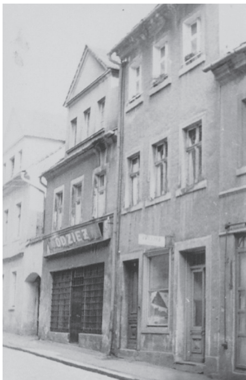
6. Budynek mieszkalny, ul. Buczka 53, ceglano-kamienny nie określono wieku oraz cech stylowych.
