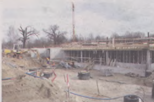
Prace na budowie krytej pływalni przebiegają zgodnie z harmonogramem
