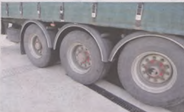
...a jeżdżąc niszczy krawężnik...
