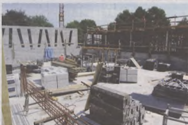
To będzie duża niecka, po prawej stronie widownia
