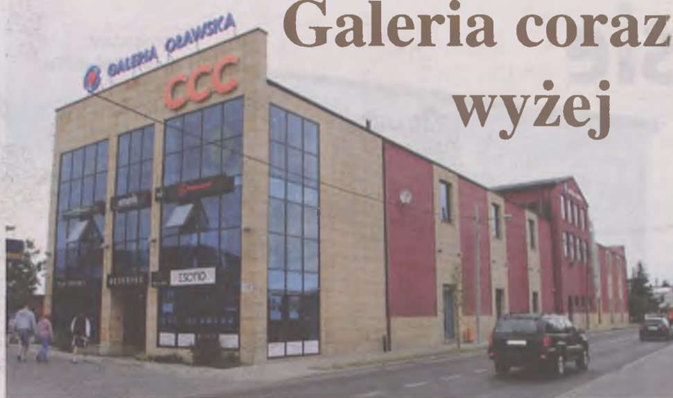
Galeria Oławska kończy rozbudowę - z zewnątrz już wygląda okazale
