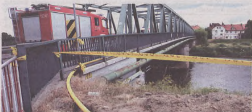
Żółta rura to tymczasowe obejście, dzięki któremu nie będzie przerw w dostawie gazu
