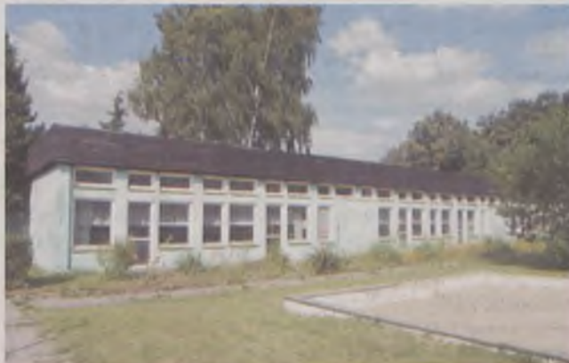
Przestarzały i wykonany w niskim standardzie budynek filii Szkoły Podstawowej w Miłoszycach wymaga remontu
