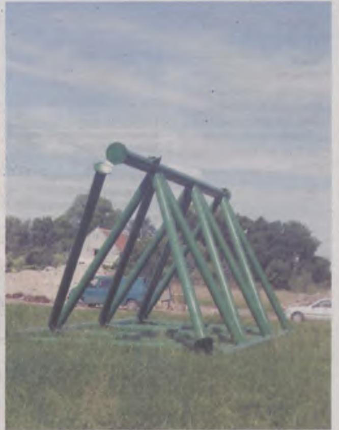
Jeden z czterech elementów wieży jest już na miejscu
