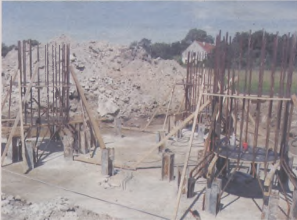
Obecnie trwają prace przy budowie fundamentów, na nich będą posadowione stalowe, kratownicowe konstrukcje wieży
