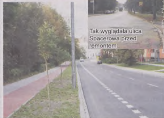
Zmodernizowana ulica Spacerowa
