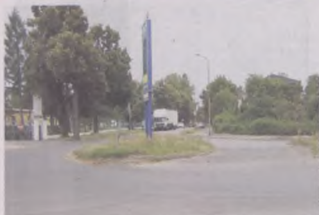
Tak wyglądało przed remontem skrzyżowanie ulic 3 Maja i Sikorskiego
