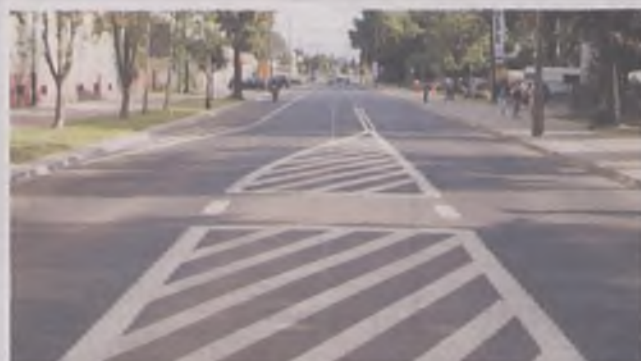
Tak wygląda zmodernizowana ulica 3 Maja, od skrzyżowania z ulicą Kasprowicza w kierunku ulicy Sikorskiego
