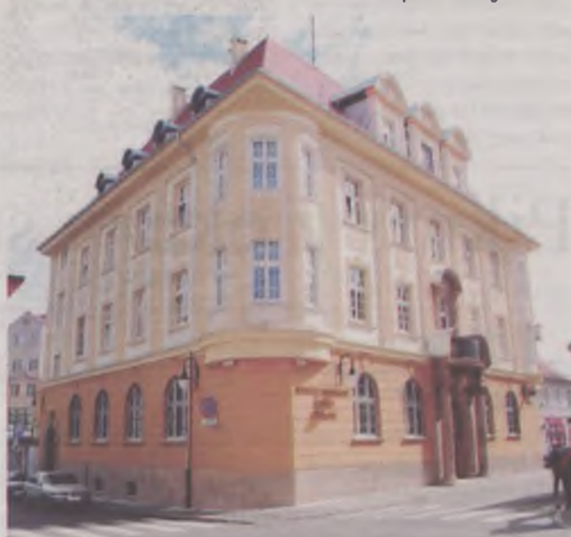
Już w przyszłym roku rozpocznie się rozbudowa oławskiej komendy
