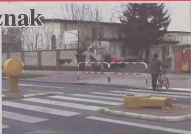
Uszkodzony znak leży już przynajmniej kilkanaście dni
