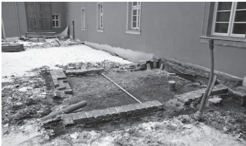
Ryc. 11. Fundamenty szamba odkryte na wirydarzu klasztoru (fot. 2013).
