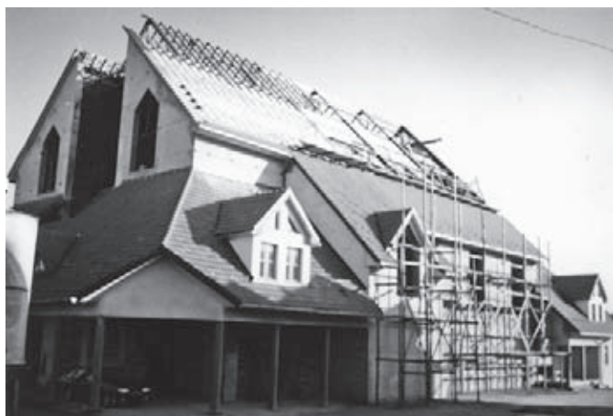
Ryc. 6. Kościół już pod dachem.
