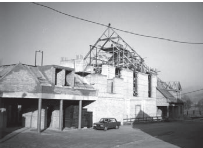
Ryc. 5. Budowa pierwszych stropów świątyni.
