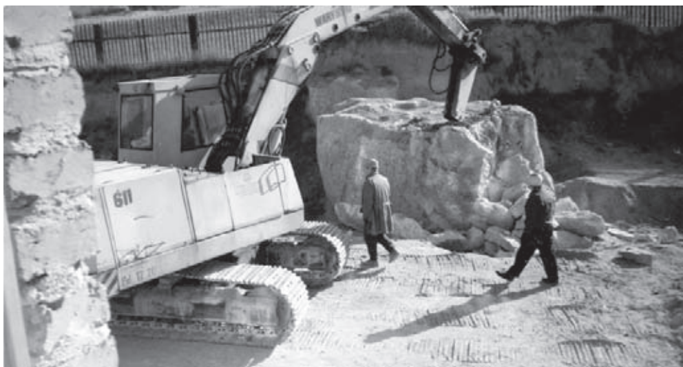
Ryc. 2. Przy budowie pomagały maszyny z ZBMP „Fampa”.
