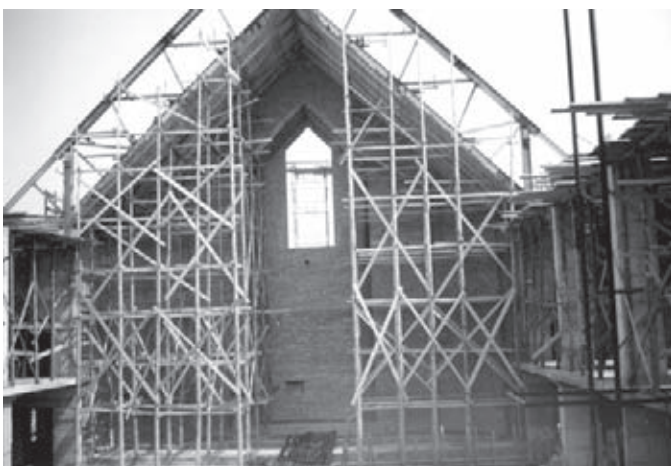
Ryc. 4. Budowa absydy kościoła Matki Bożej Miłosierdzia.
