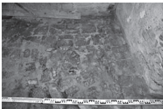
Ryc. 8. Bruk kamienny w korytarzu wschodniego skrzydła klasztoru (fot. 2013 r.).
