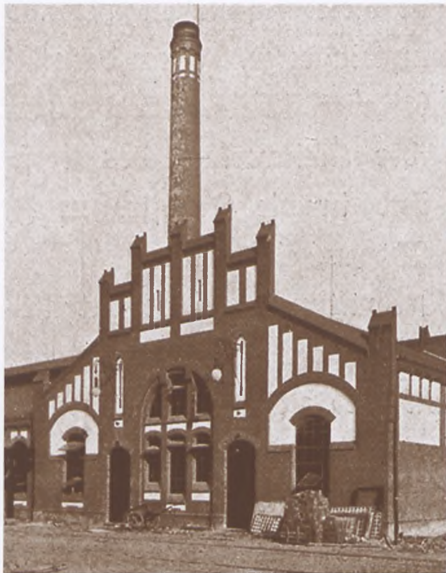
Budynek maszynowni tarnogajskiej gazowni (1906 r.)
