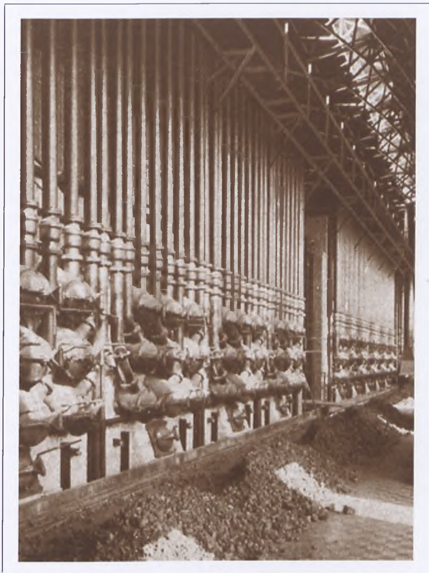
Piece retortowe Gazowni W na Tarnogaju we Wrocławiu (1906 r. )
