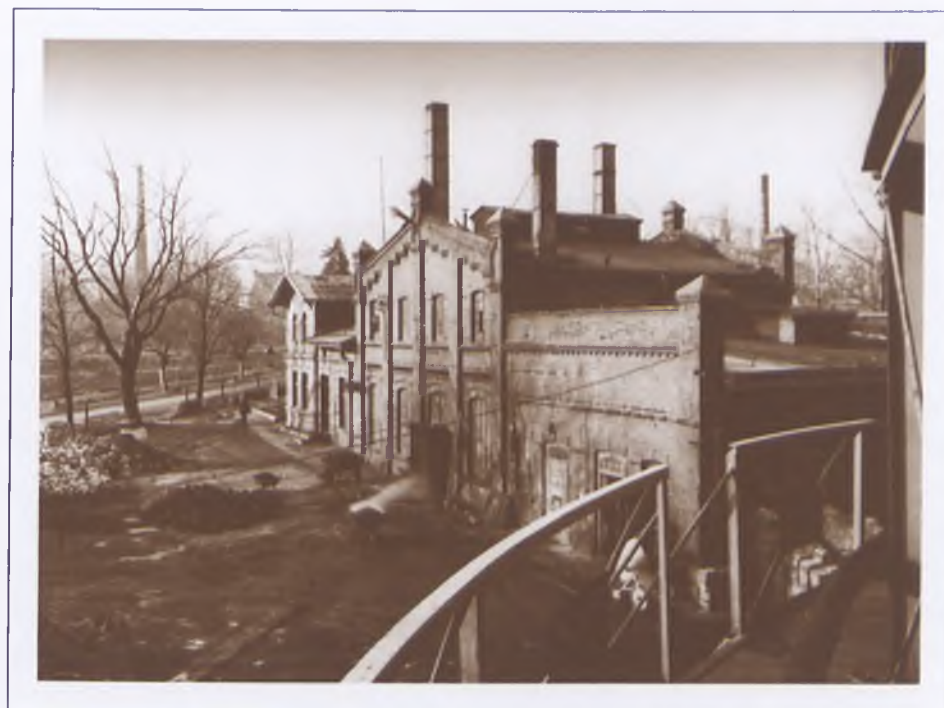
Widok gazowni w Sobótce (1978 r, foto. J. Stałmarski)
