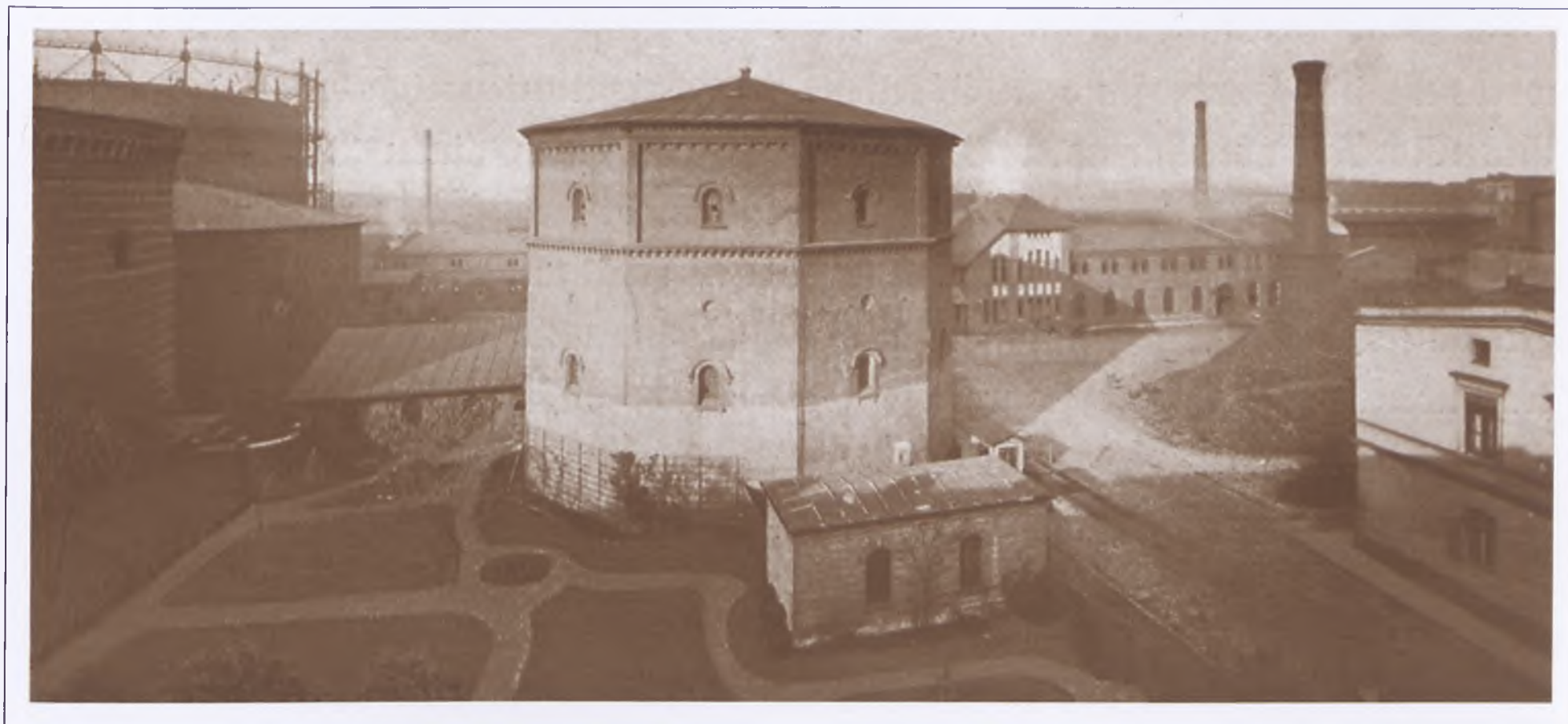
Widok ogólny Gazowni I przy ul. Tęczowej we Wrocławiu (pocz. XX w.)
