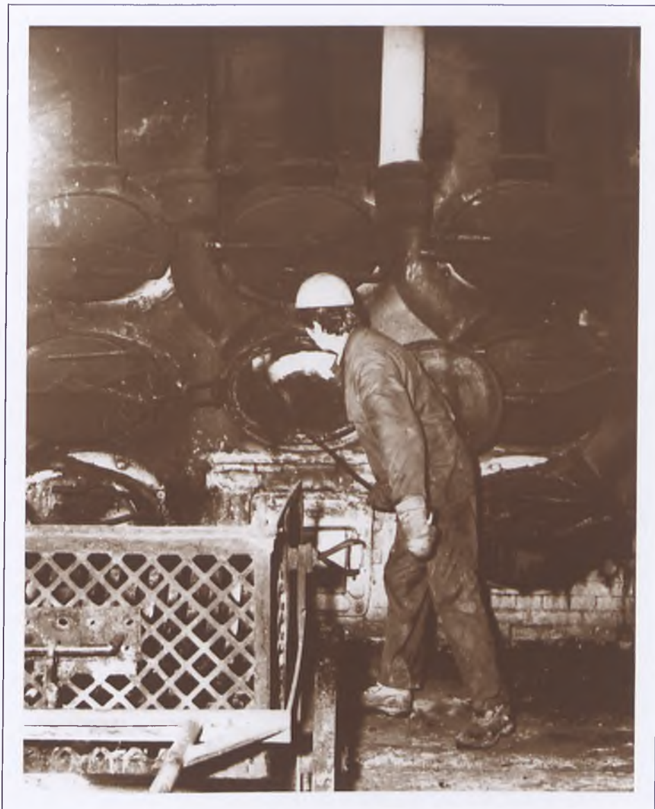
Nowoczesne dmuchawy zainstalowane w gazowni II w Żgorzcu (pocz. XX w.)
