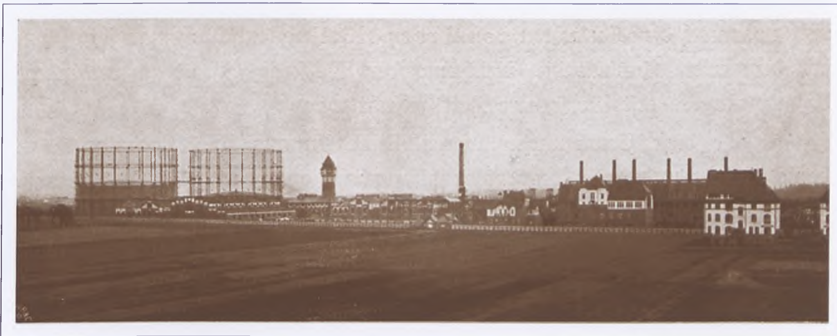
Widok ogólny Gazowni IV na Tarnogaju w okresie budowy (1906 r.)
