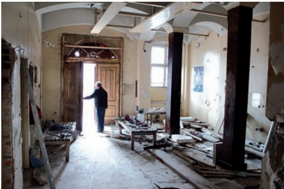
Dawną pracownię rentgenowską ktoś zdążył już mocno prześwietlić.
