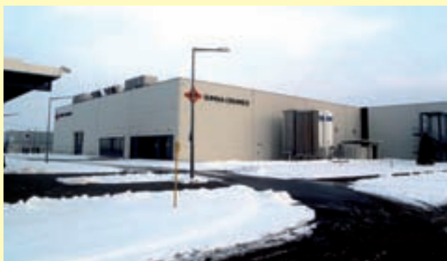
Fabrykę Sumika Ceramics Elektromont wyposażył kompleksowo w instalacje elektryczne.
