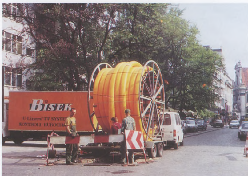
Renowacja gazociągu Dn 400, ul. Kuźnicza, rok 1996
