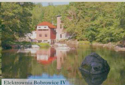
Elektrownia Bobrowice IV
