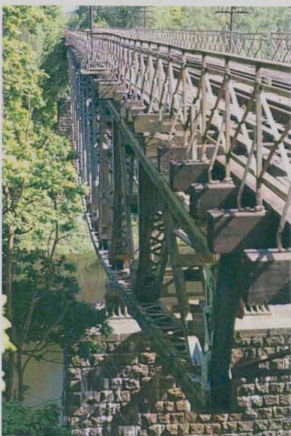
Ryc. 28. Most kolejowy w Pilchowicach nad zbiornikiem
