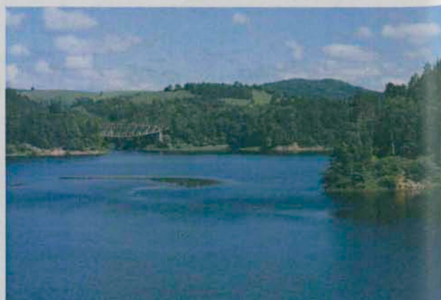
Ryc. 25. Most kolejowy w Pilchowicach nad zbiornikiem
