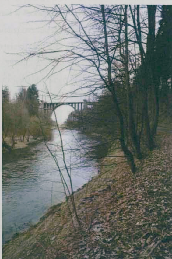
Ryc. 29. Most kolejowy w Jeleniej Górze nad rzeką Bóbr
