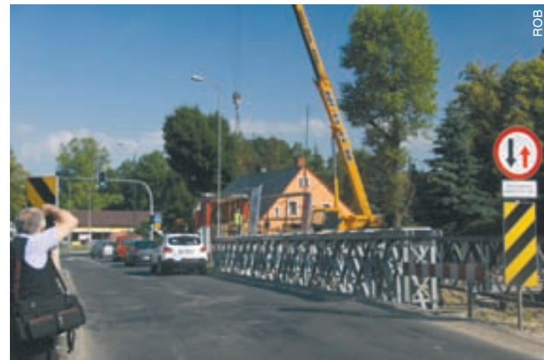
Tymczasowy most w Maciejowej zostanie w tym tygodniu rozebrany.
