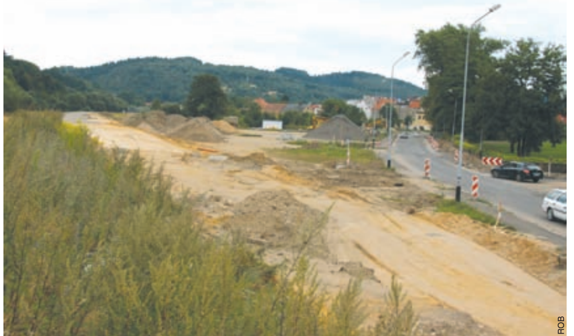
Budowa obwodnicy ma zakończyć się ostatniego października.
