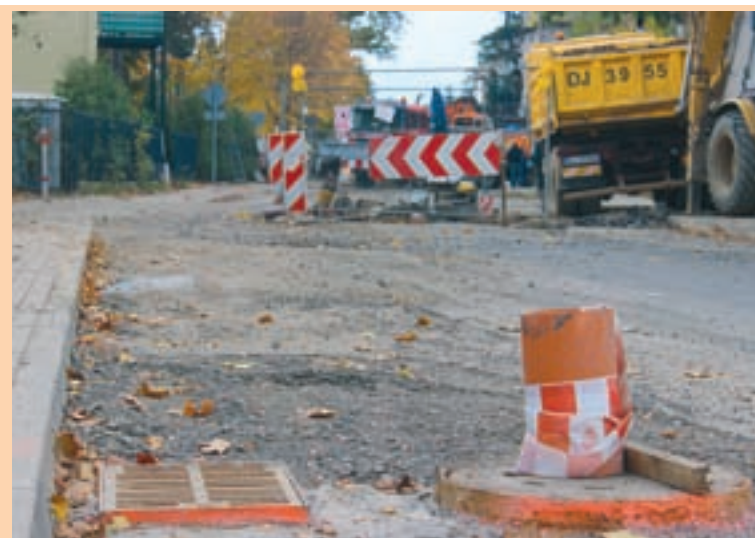
Widok rozkopanej ulicy nie budzi optymizmu u mieszkańców.
