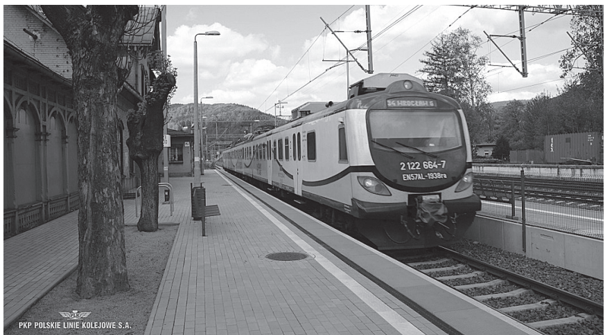
Wyremontowana stacja w Piechowicach jest przyjazna dla osób niepełnosprawnych.
