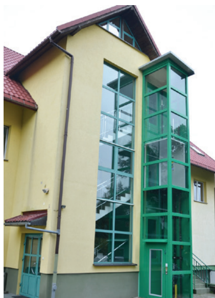
Budynek Nadleśnictwa Międzyzylesie jest wyposażony w windę zewnętrzną.
