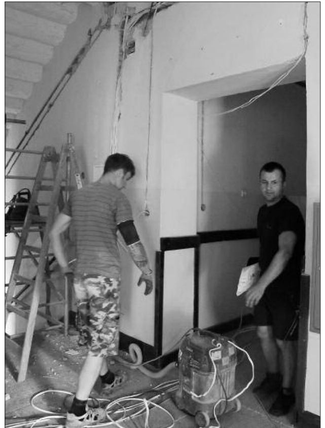
Wymiana instalacji w SP 4 to duże zadanie - nowa sieć zostanie zamontowana zarówno w budynku dydaktycznym, jak i sali gimnastycznej
