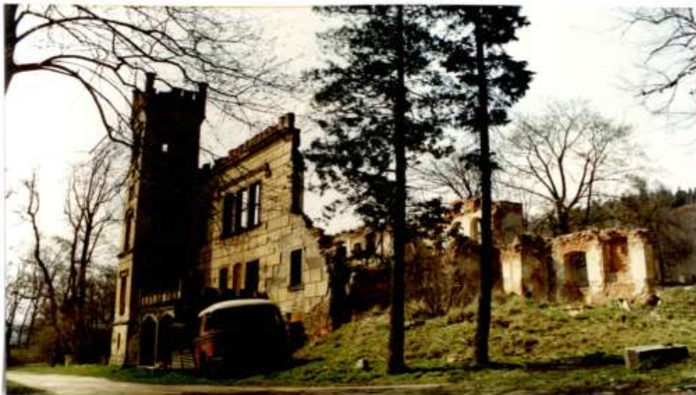
Ruina pałacu Deckerów – stan z 1995 roku.
