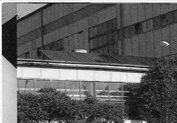
Wykonanie instalacji na dachu płaskim
