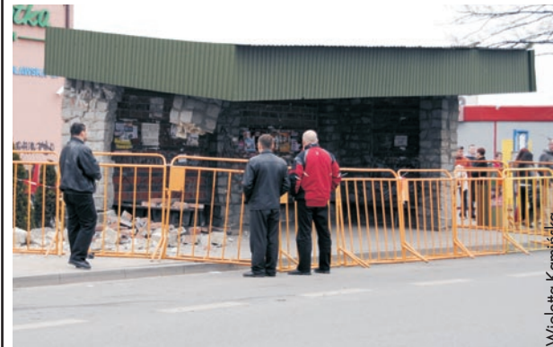
Po wypadku murowany przystanek rozebrano. Na jego miejscu stanie szklana wiata
