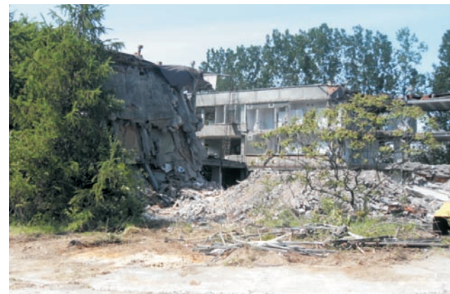
Bardzo sprawnie postępuje rozbiórka budynku, w którym mieścił się ZOETO
