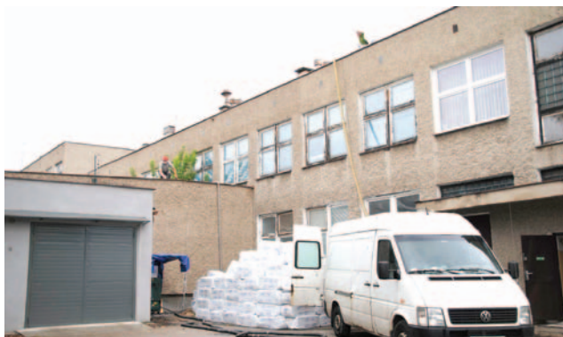
Termomodernizację budynku szkoły przy al. Młodych w Jelczu-Laskowicach rozpoczęto od naprawy dachu
