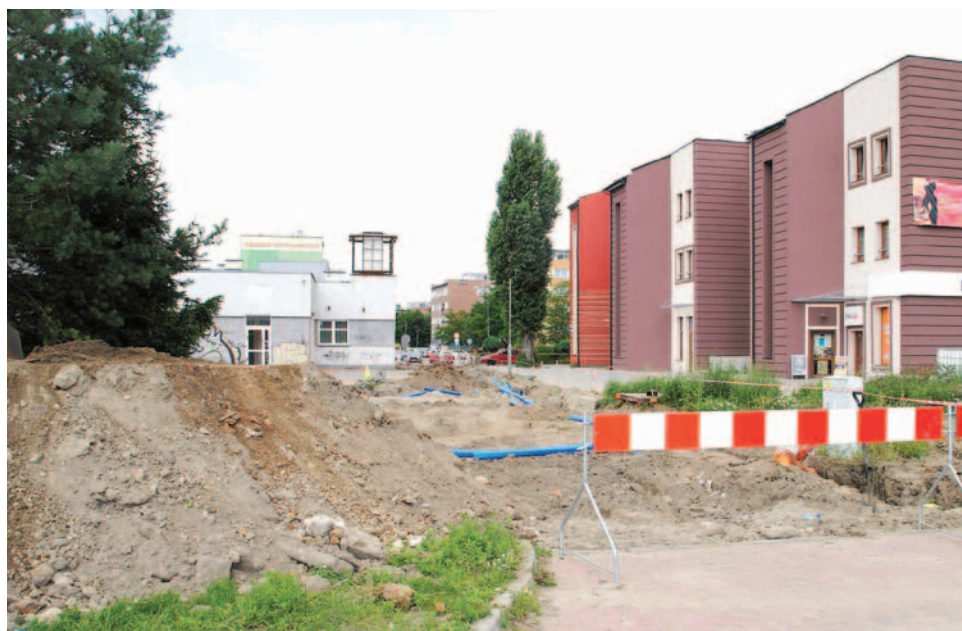
Rozpoczął się drugi i trzeci etap remontu ulicy Bożka - to m.in. budowa łącznika z Oławską oraz zagospodarowanie terenu wokół przychodni
